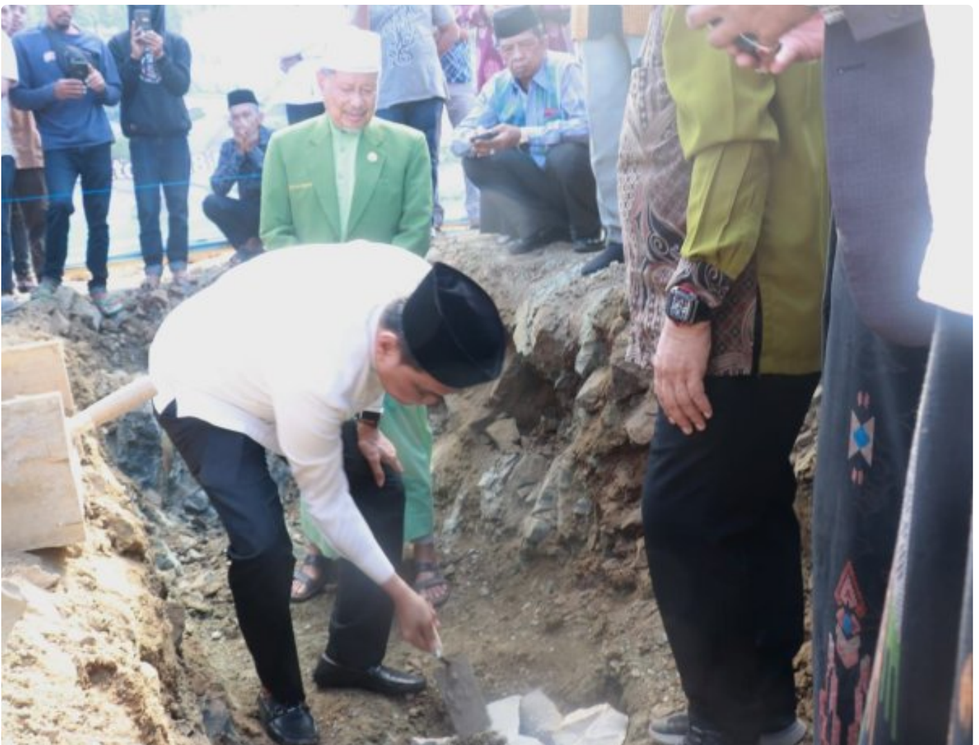
Bupati Barru Ir. H. Suardi Saleh, M.Si., saat meletakkan batu pertama pembangunan Ponpes modern Jabal Uhud Bottolai
